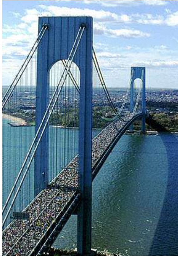
Şekil 1. New York Verrazona Köprüsü – New York Maratonu
