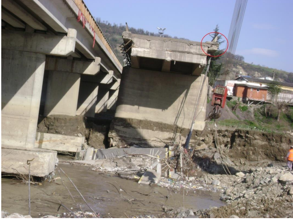
Resim – 2. Yıkılan Çaycuma Köprüsünün Tabliyesi ve Yapılan Ekleme!
