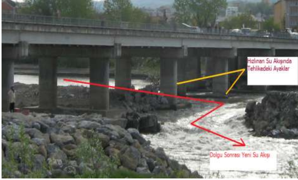
Fotoğraf 4- Çaycuma Köprüsünde oluşturulan dolgu nedeniyle değişen akım
