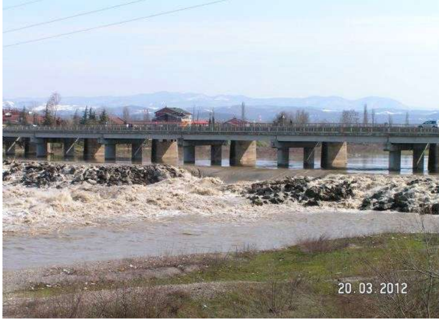
Fotoğraf 3: Çaycuma Köprüsünde kırılan taş set http://www.caycumasanat.com/oku.asp?id=2315 )
