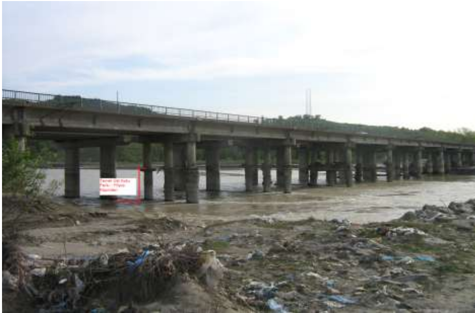
Fotoğraf 1 – Filyos Köprüsü (Çaycuma köprüsünün 10 km membaında)
